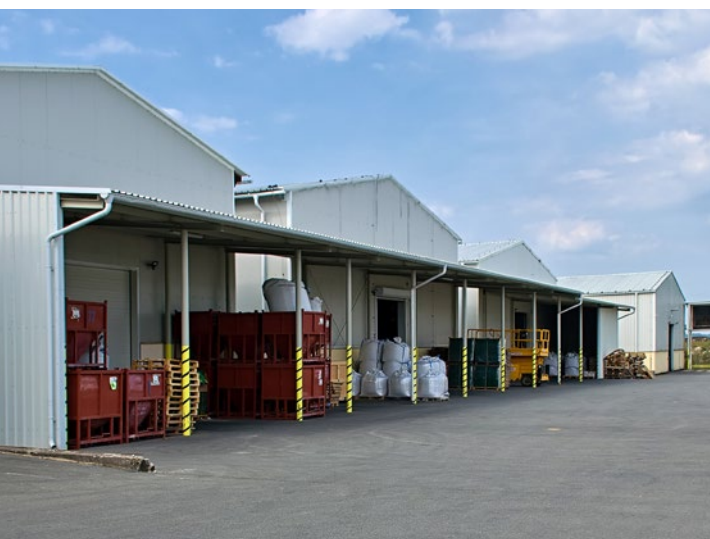
Areál posklizňové linky a skladů ve Vysokém Mýtě
