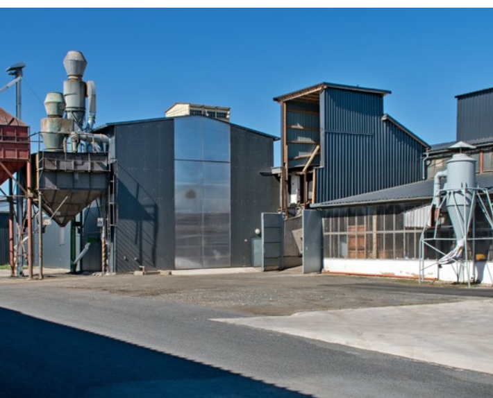
Areál posklizňové linky a skladů v Horažďovicích
