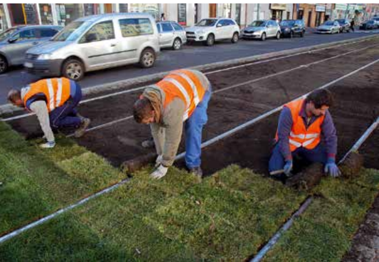
Pokládka travních koberců na tramvajové trati v Praze – listopad 2021
