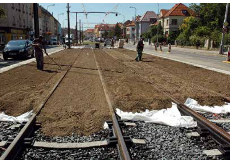
Technologie přípravy tramvajové trati před pokládkou travních koberců
