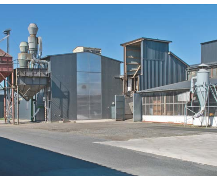
Areál posklizňové linky a skladů v Horažďovicích
