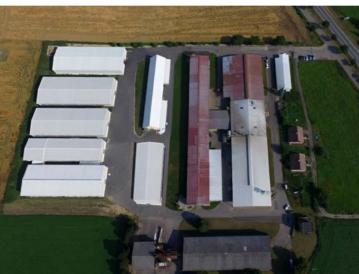
Areál skladů a posklizňové linky
